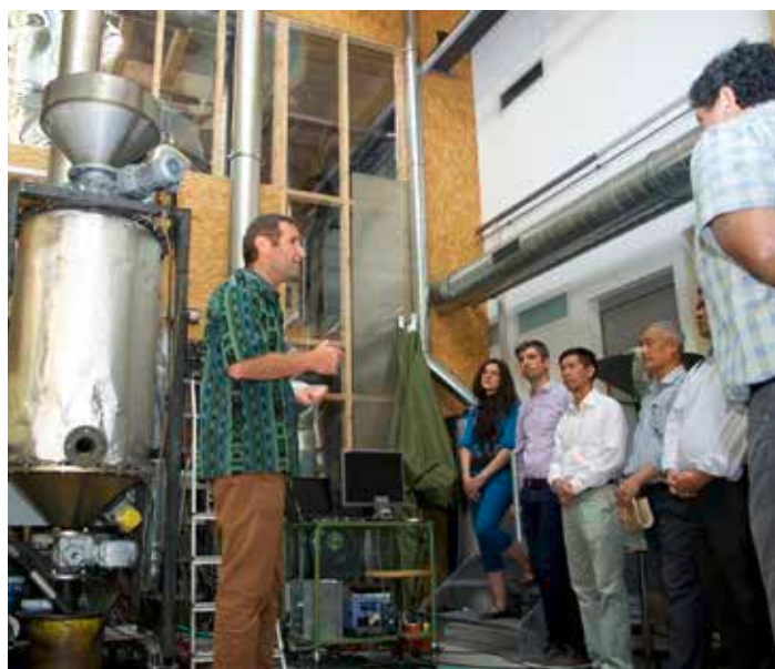
Anlässlich des Technologietransfer-Workshops erklärt Martin Schmid vom Ökozentrum Vertretern von peruanischen und vietnamesischen Unternehmen, wie die Pyrolyse-Anlage funktioniert.
